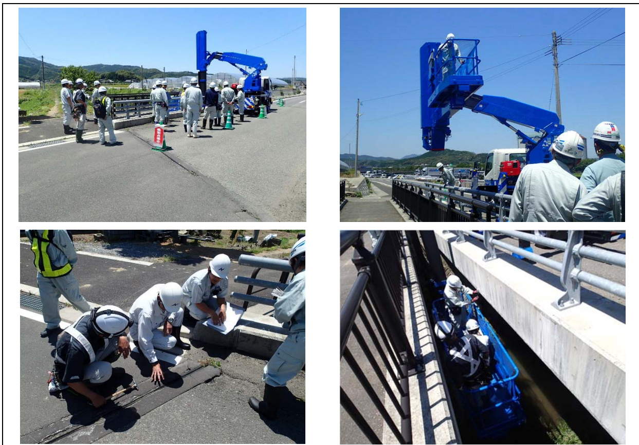
現地点検実習状況
